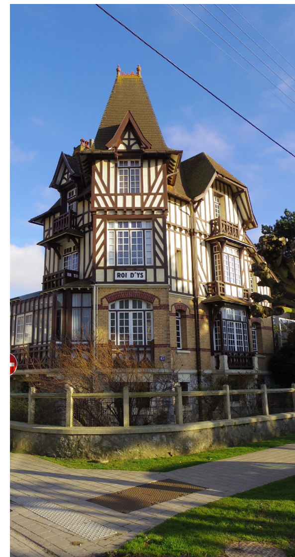
Les formes de toitures et les matériaux de couverture d'origine seront conservés ou restitués.
