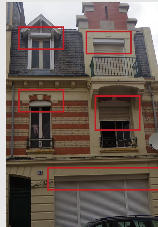
La pose de coffrages de volets roulants extérieurs sur le domaine public est interdite.
