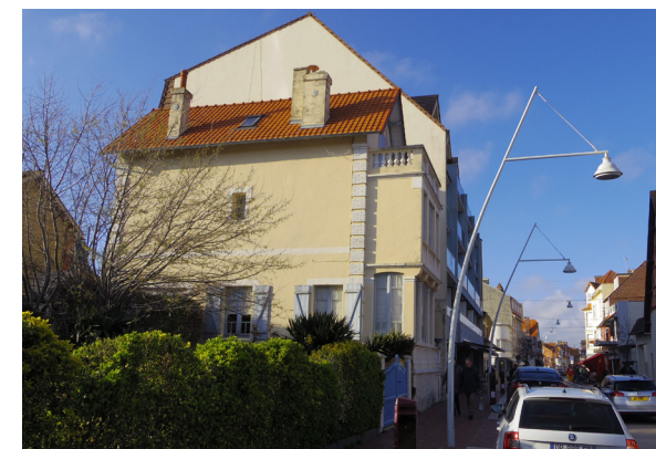
Les formes de toitures et les matériaux de couverture d'origine seront conservés ou restitués.
