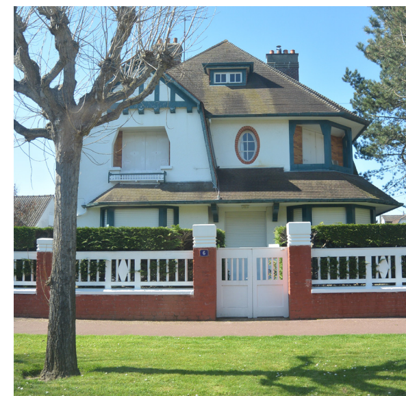
La clôture fait partie intégrante de la façade
