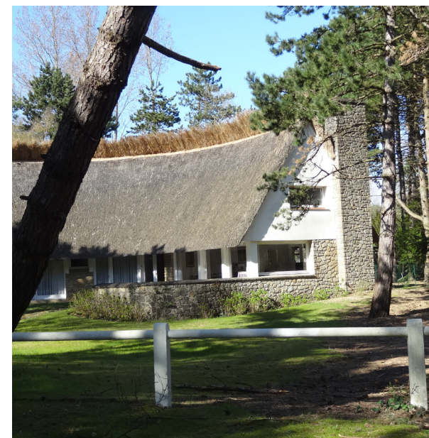
Les formes de toitures et les matériaux de couverture d'origine seront conservés ou restitués.
