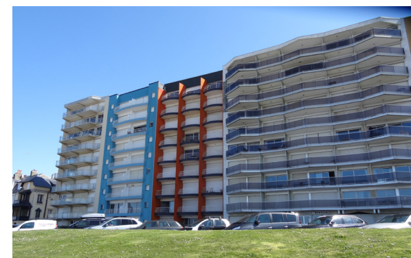
Les collectifs marquent la façade maritime par leur rythme et leur couleur
