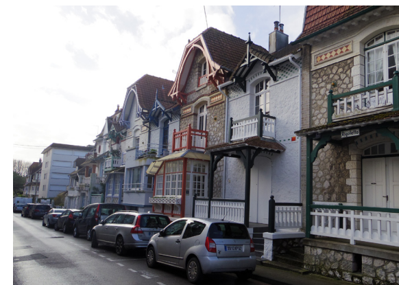
Les formes de toitures et les matériaux de couverture d'origine seront conservés ou restitués.
