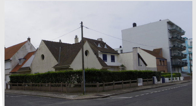
En bordure du quartier, des petits immeubles collectifs présentent des hauteurs plus élevées.
