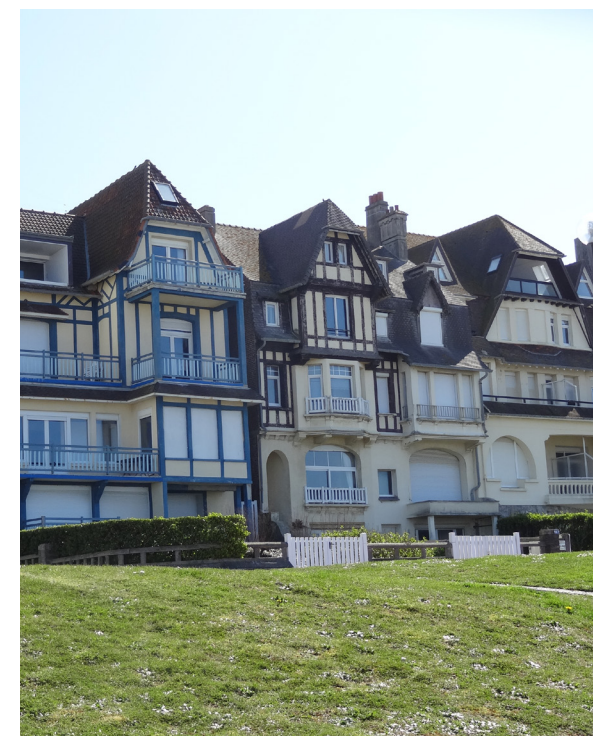
Les formes de toitures et les matériaux de couverture d'origine seront conservés ou restitués.
